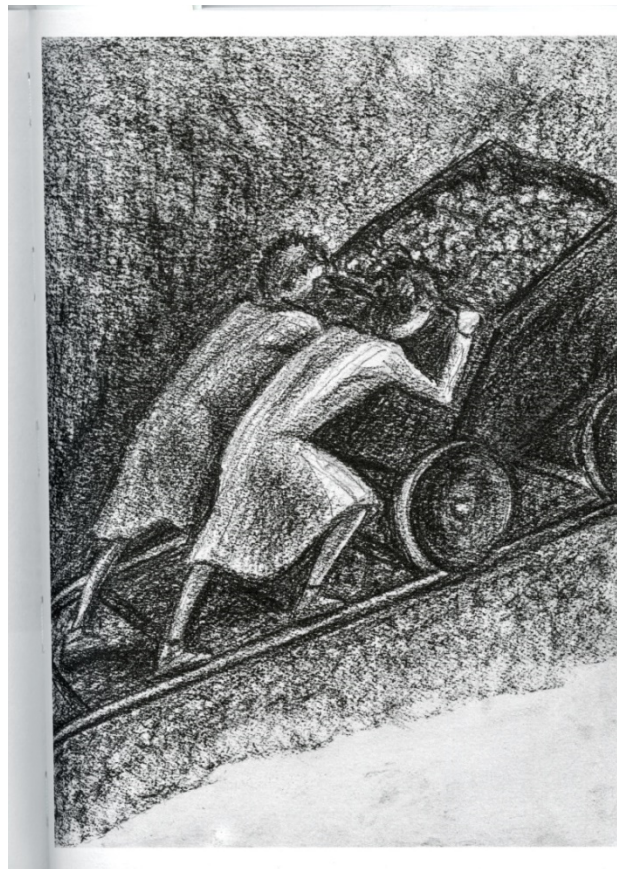
« Construction d'une route »
