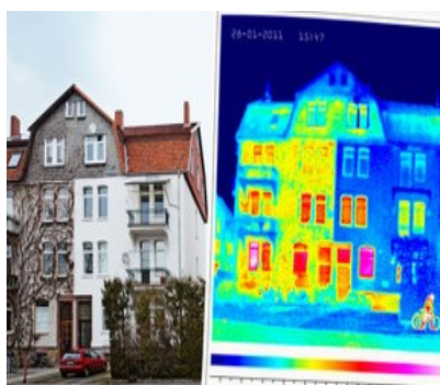
Image thermique d'un immeuble dont une partie seulement est isolée © Ingo Bartussek/Adobe Stock
