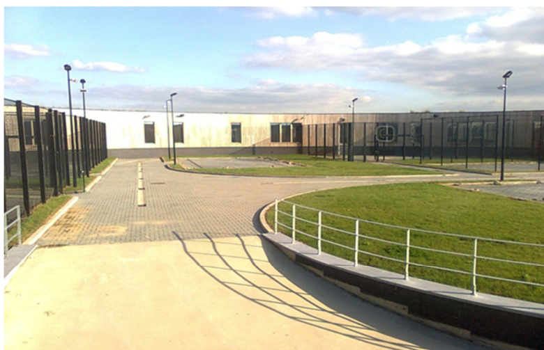
Vue de la cour intérieure
