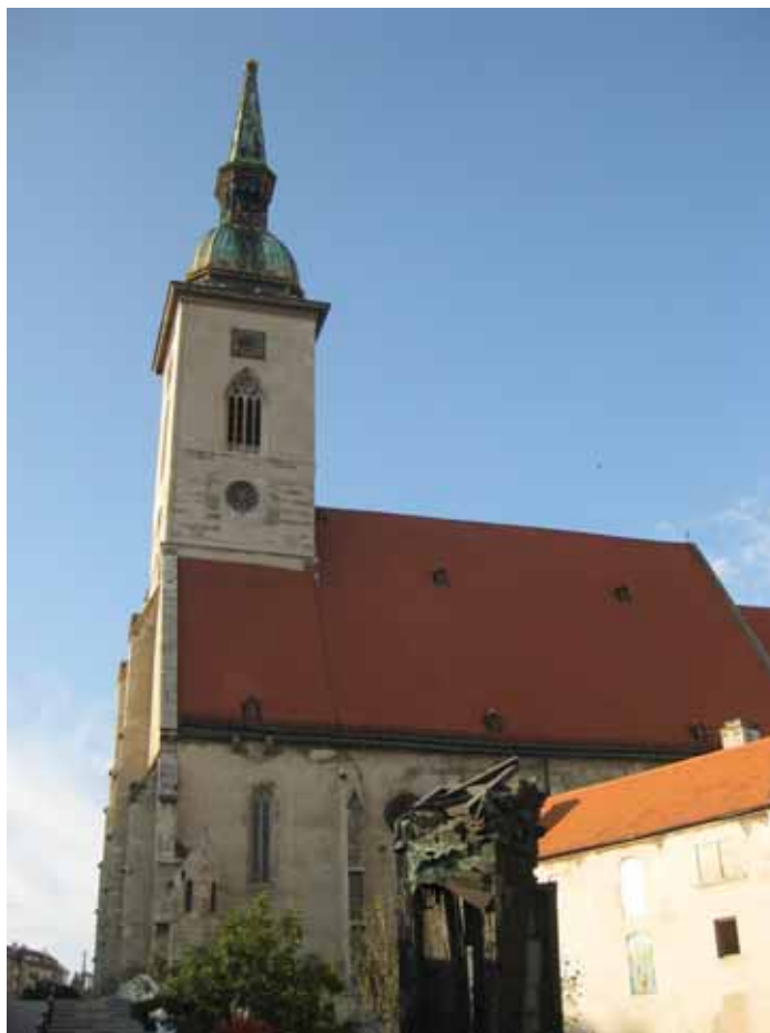
Église des couronnements Bratislava
