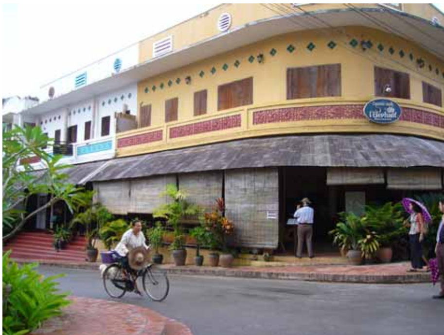
Exemple de bâtiment de la période coloniale
